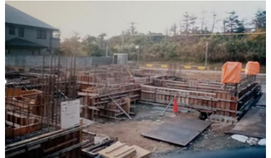
⑥基礎工事の様子。増築された場所の角に池があり、お祓いをして、湧水配管もたくさん通しています。
